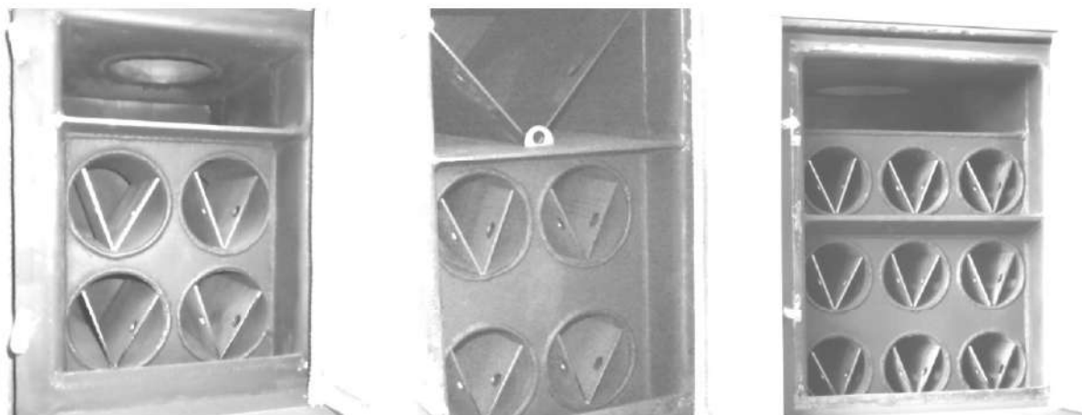
Рисунок 4 – Схема установки турбулизаторов
